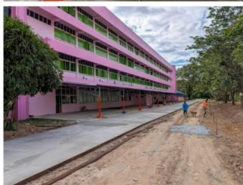
หลังอาคารเรียน 4
