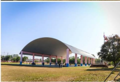
อาคารโดมเอนกประสงค์
